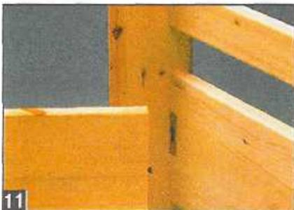
11 Соединение продольных царг со спинками кроватей делают легко разборным. Для большей надежности это соединение дополнительно усиливают шурупами, ввинченными через вертикальные стойки спинок в продольные царги.
