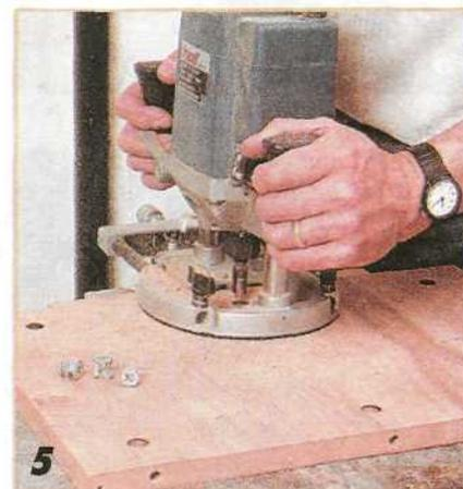
5 Глухие отверстия для установки деталей мебельного крепежа выберите 15-мм фрезой.
