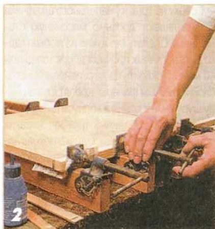
2 С помощью ПВА и струбцин окантуйте все видимые ребра деревянным шпоном 2x20 мм. Чтобы равномерно распределить усилие прижима, под губки струбцин подложите бруски-прокладки.
