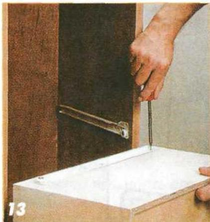
**13** Разметьте положение деталей выдвижного механизма и прикрепите их 13-мм шурупами.
