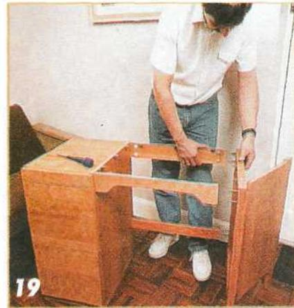
**19** Соберите стол. Прикрепите откидную часть крышки стола к неподвижной части на ролевой петле. Царги стола и стяжку прикрепите к тумбе на шкантах. Крышку установите в последнюю очередь.
